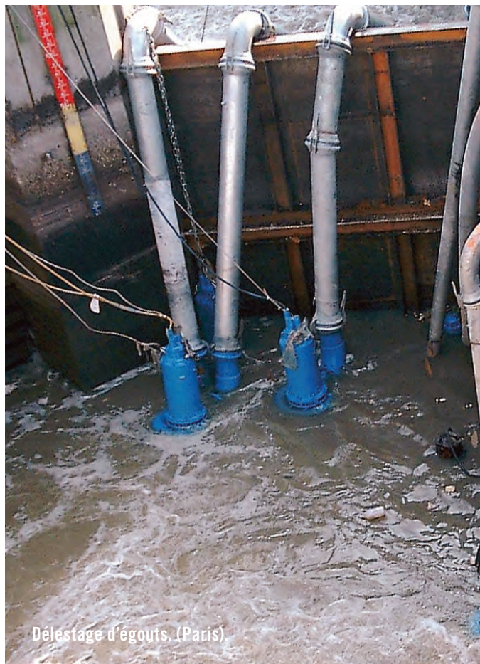
Évacuation des eaux suite à une rupture de digue. (Arles - Bouches du Rhône).
