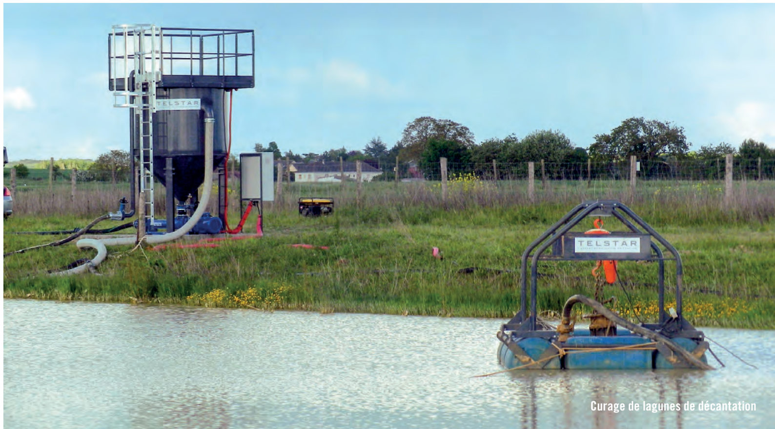
Épuisement d’eaux de ruissellement
