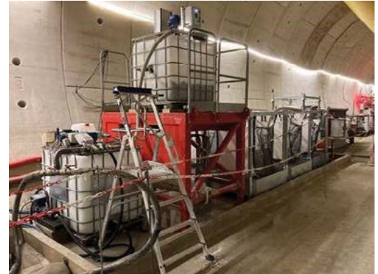
Installation sur la ligne 15 - T3A
