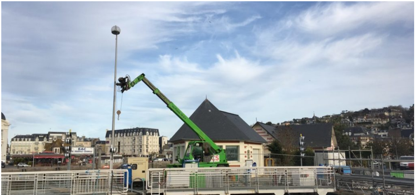
Le batardeau côté mer
