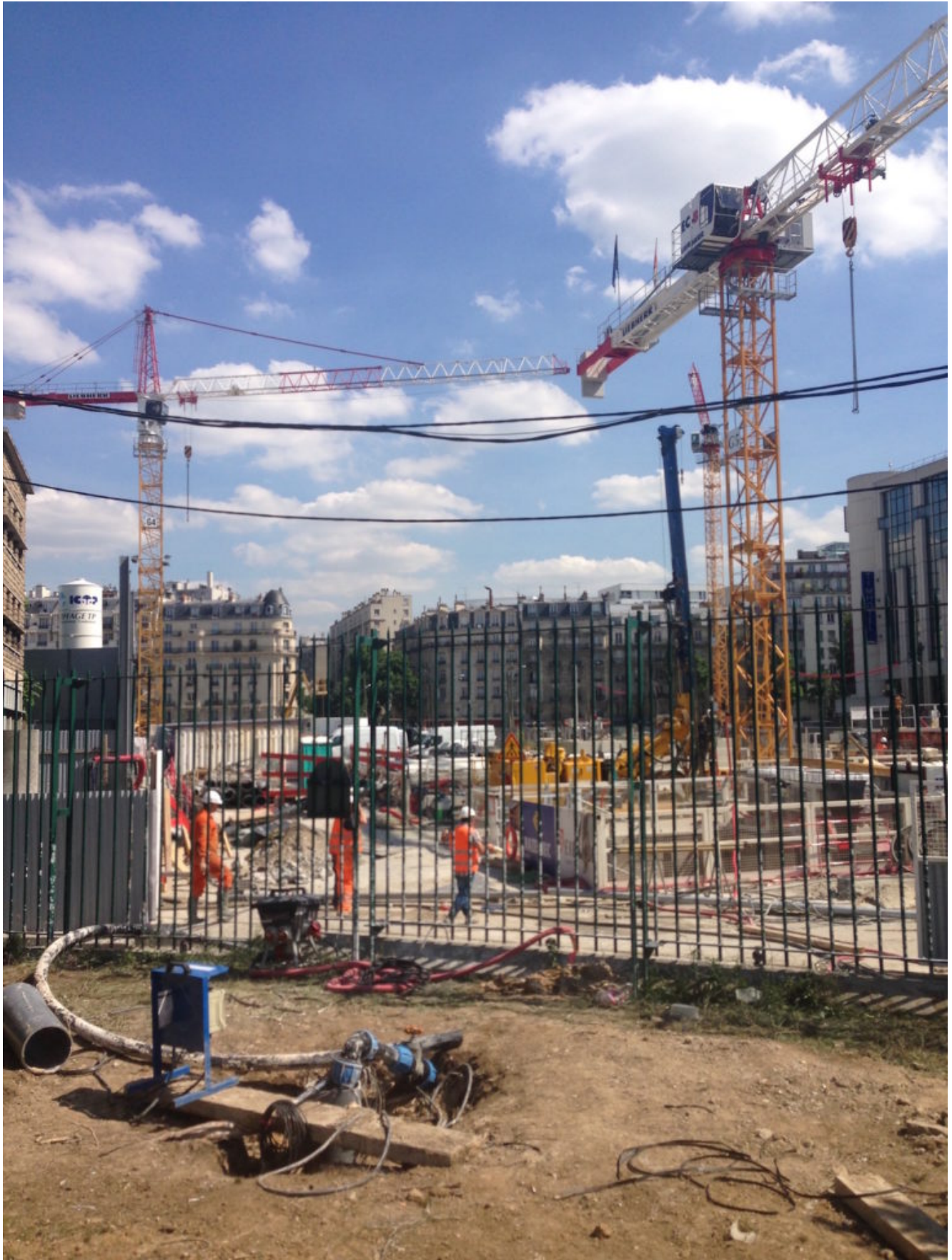
Le rabattement de nappe à effectuer à côté de la zone de pompage
