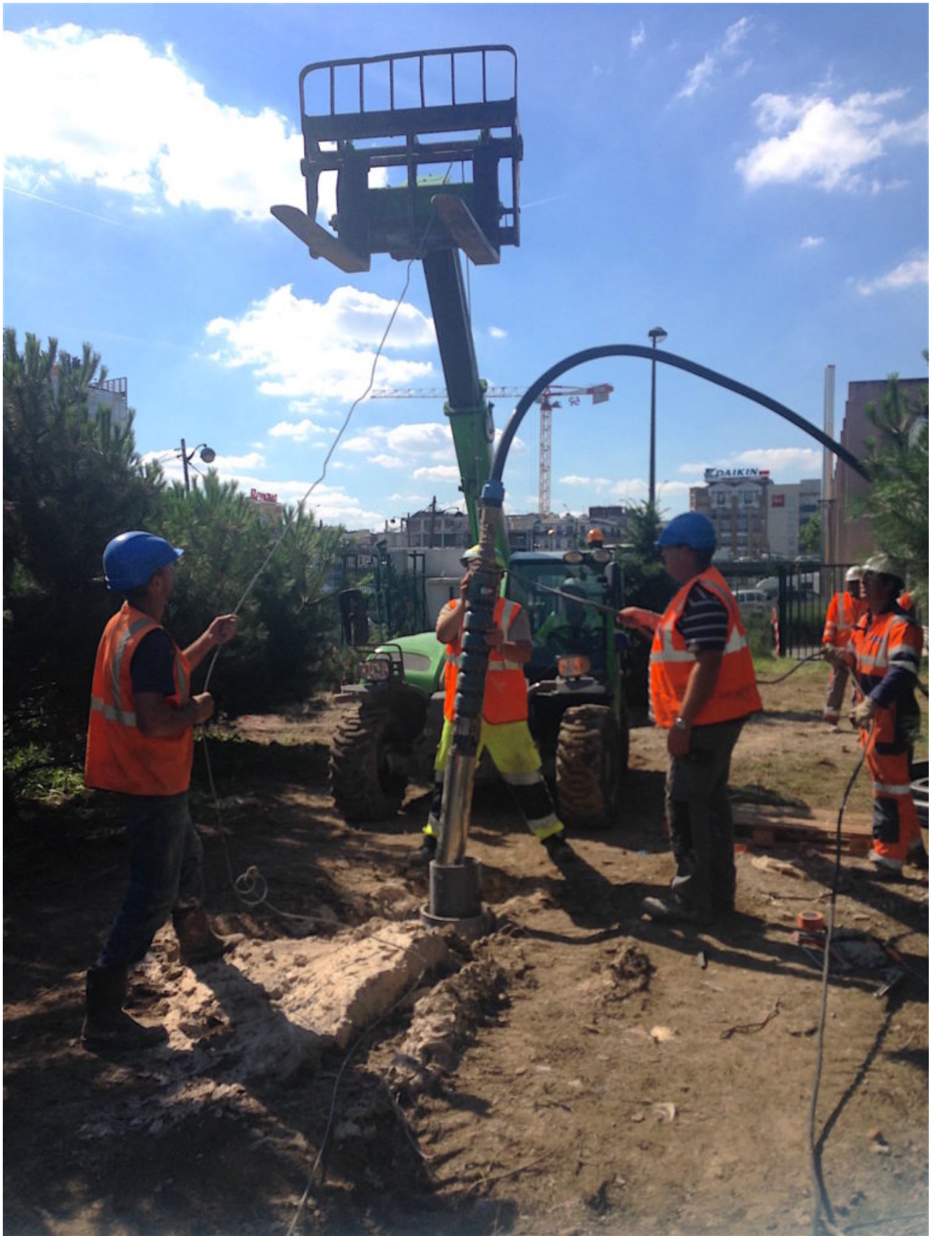
L'installation des pompes sur la ligne 14 du métro parisien
