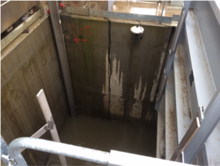
La fosse où la Grindex doit être déposée
