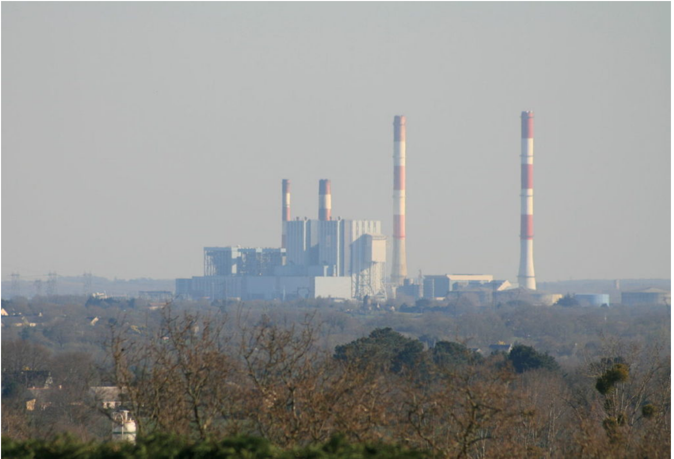
la centrale de Cordemais
