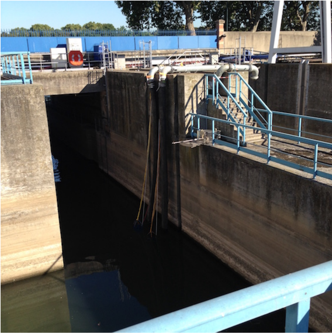
Les 2,10 F K sont installées...
