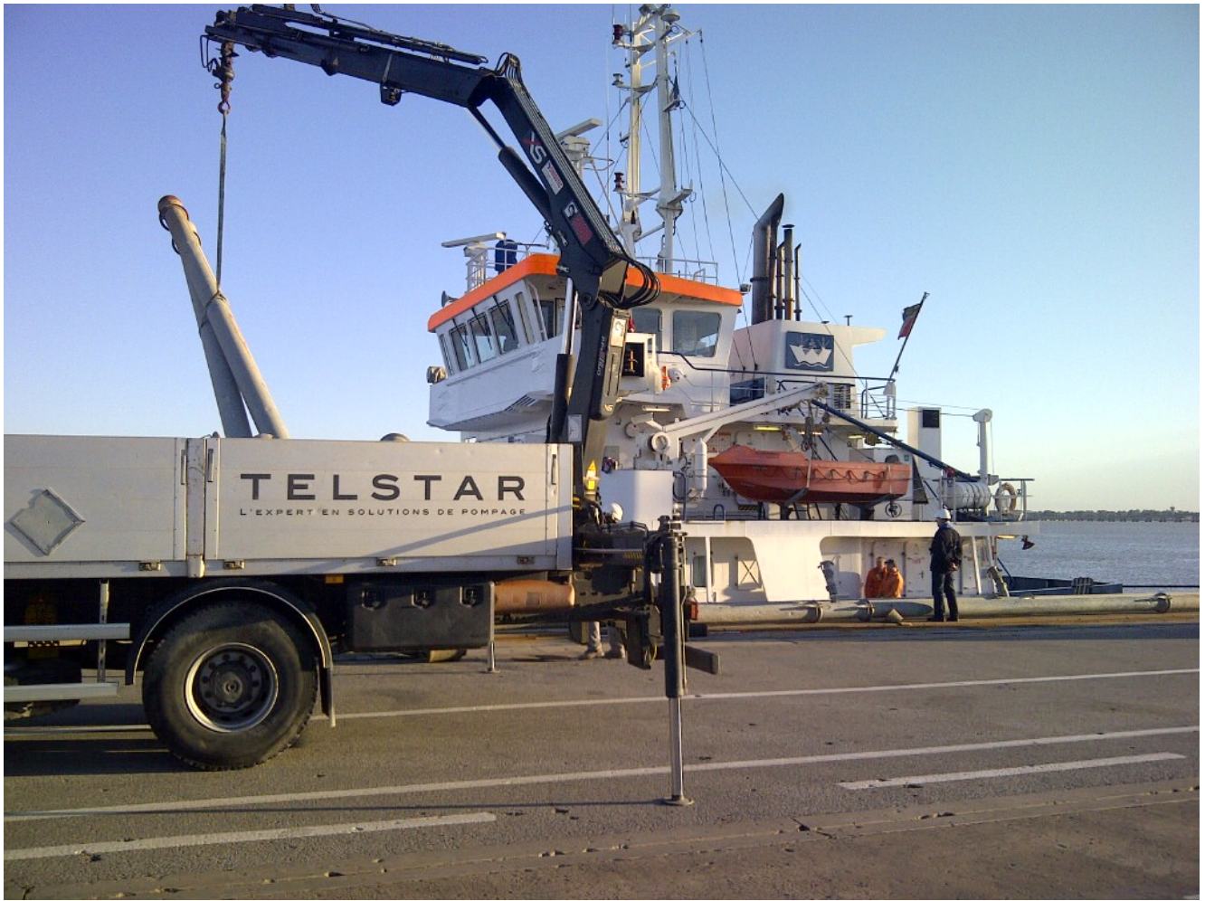
L'installation des refoulements
