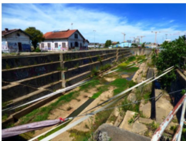
La Forme 1 : le bassin de radoub à réhabiliter
