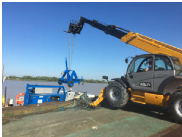
Chargement du matériel
