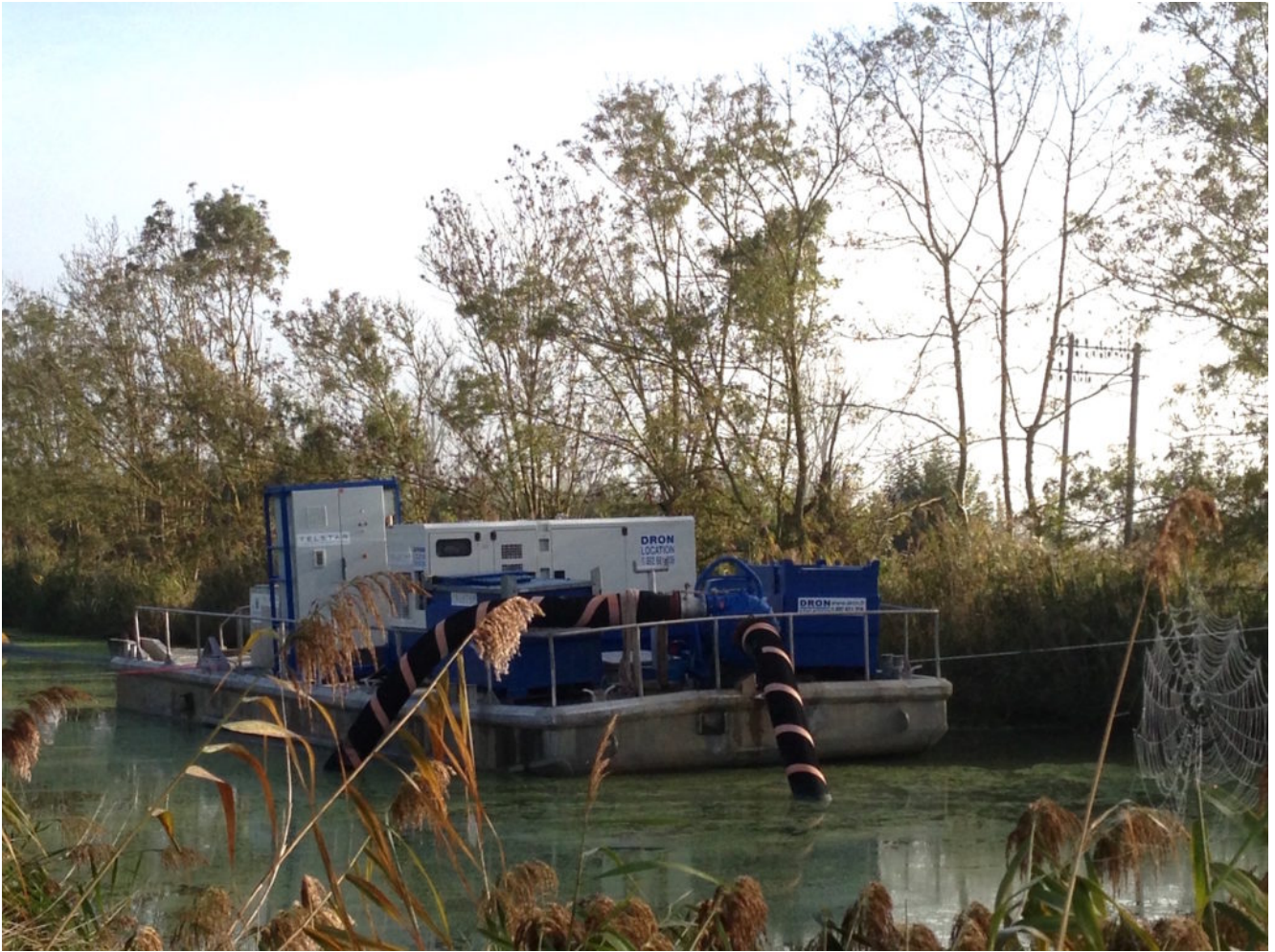
La barge équipée de tout son matériel
