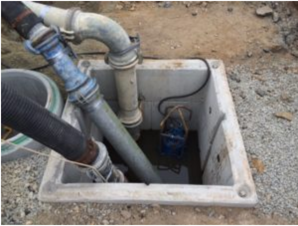
Le départ des 3 lignes de refoulement avec la F06-K en place
