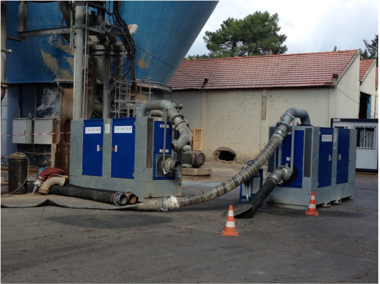
L'installation des 2 Hidrostral
