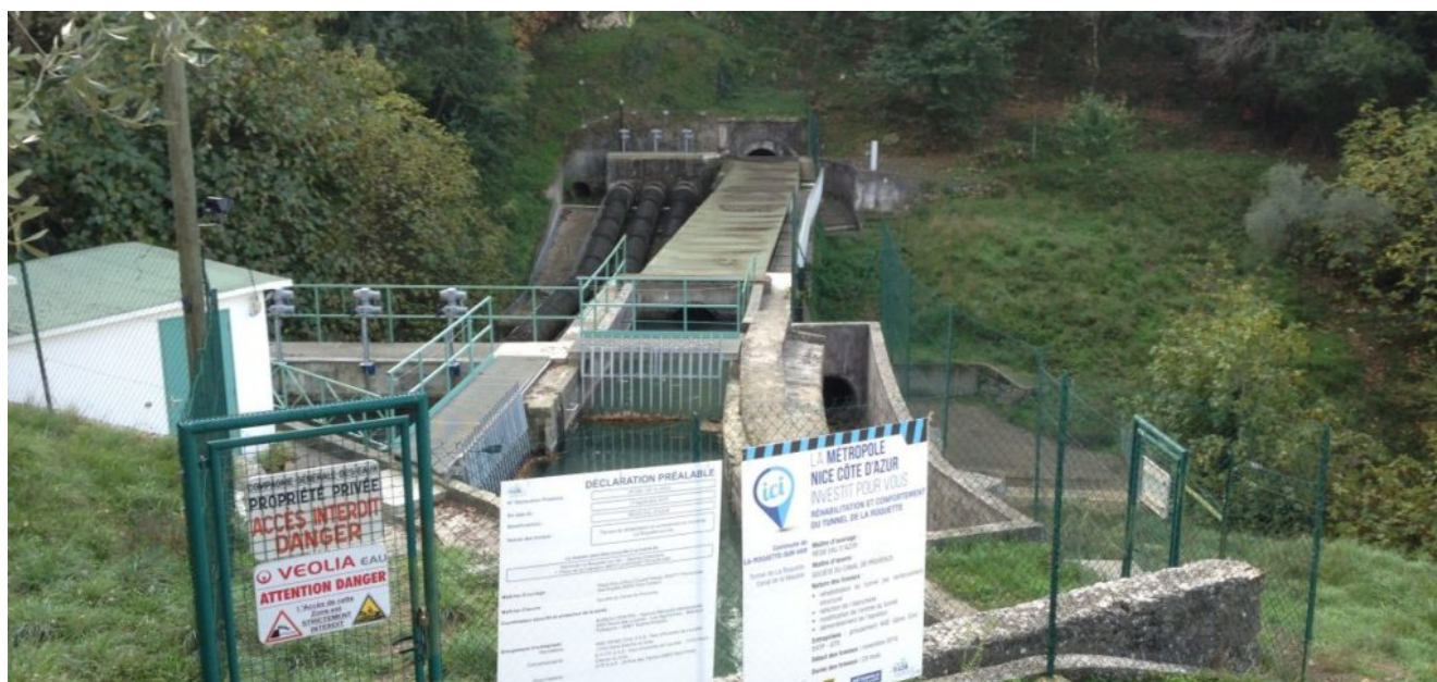
Le tunnel en travaux
