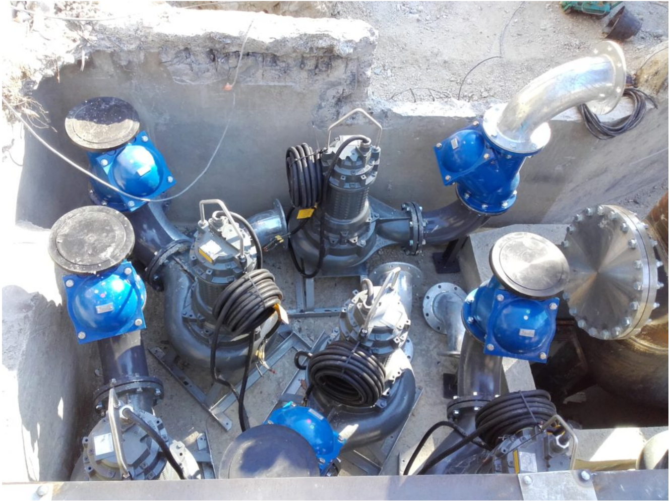
Mise en place des six pompes Subo dans le bassin
