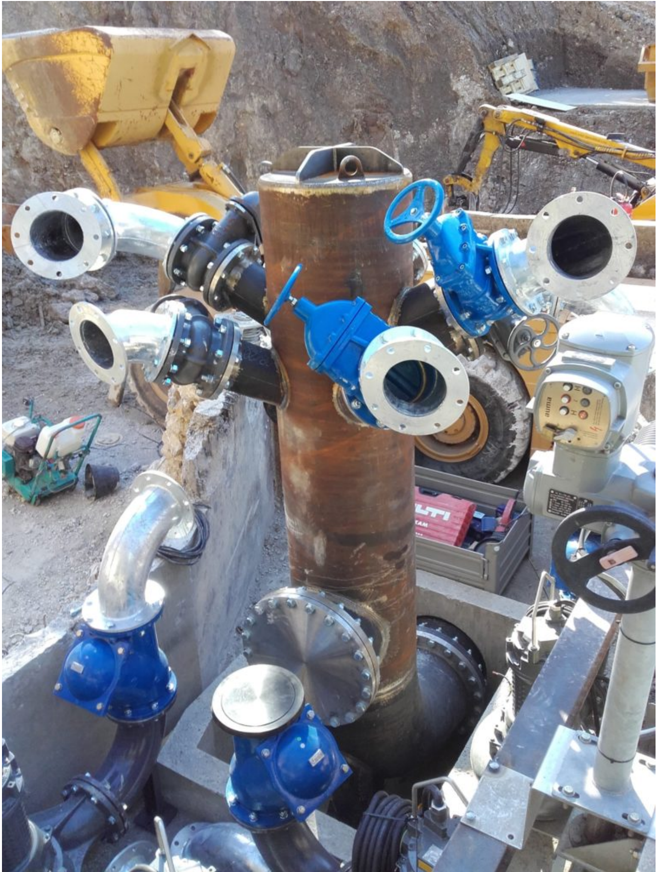
Début des branchements sur la pièce de piquage
