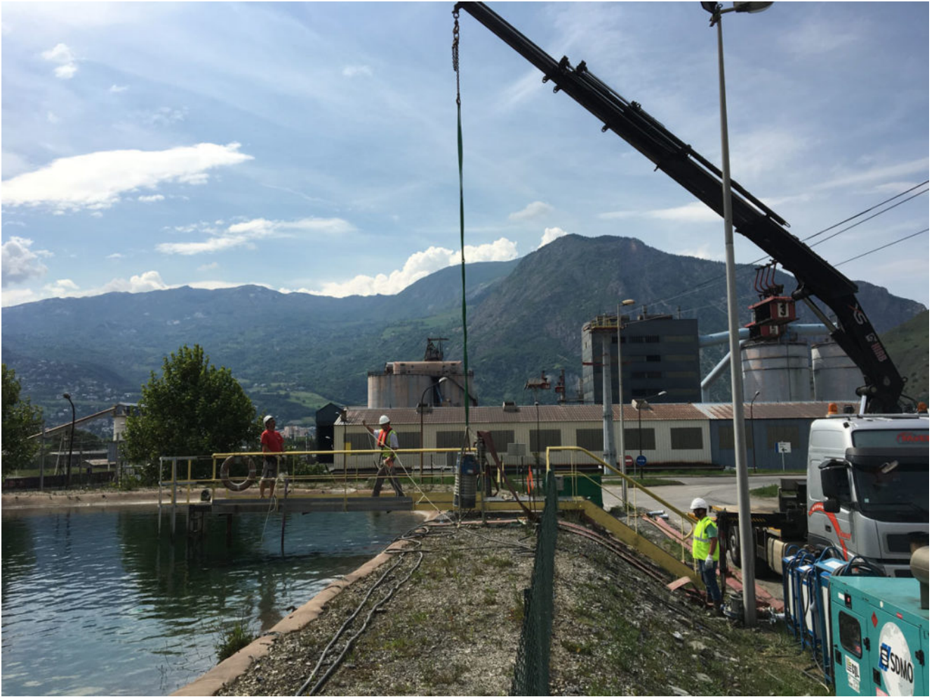
Installation des Matador dans le bassin
