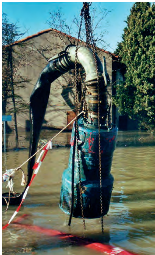
Évacuation des eaux suite à une rupture de digue. (Arles - Bouches du Rhône).
