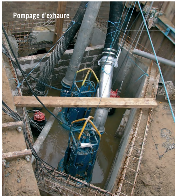
By-pass de station d'épuration
