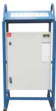
CK - Compteur électrique
